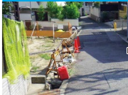
落下防止柵を設置(須磨区千守町2丁目)
