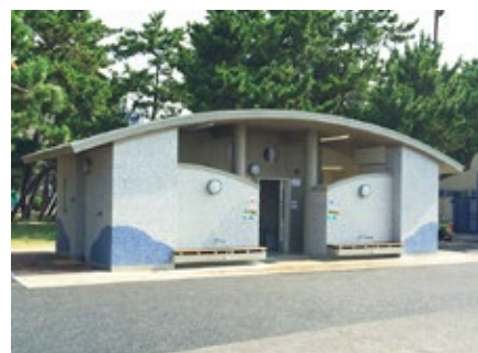
ユニバーサルトイレに改築(須磨海浜公園)
